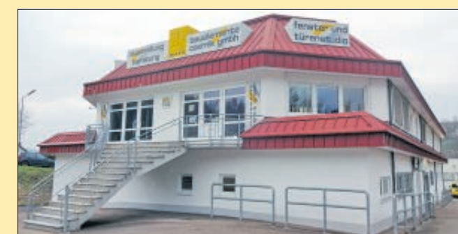
Die Baelemente Czernik GmbH in der Ziegelwaldstraße 14.
